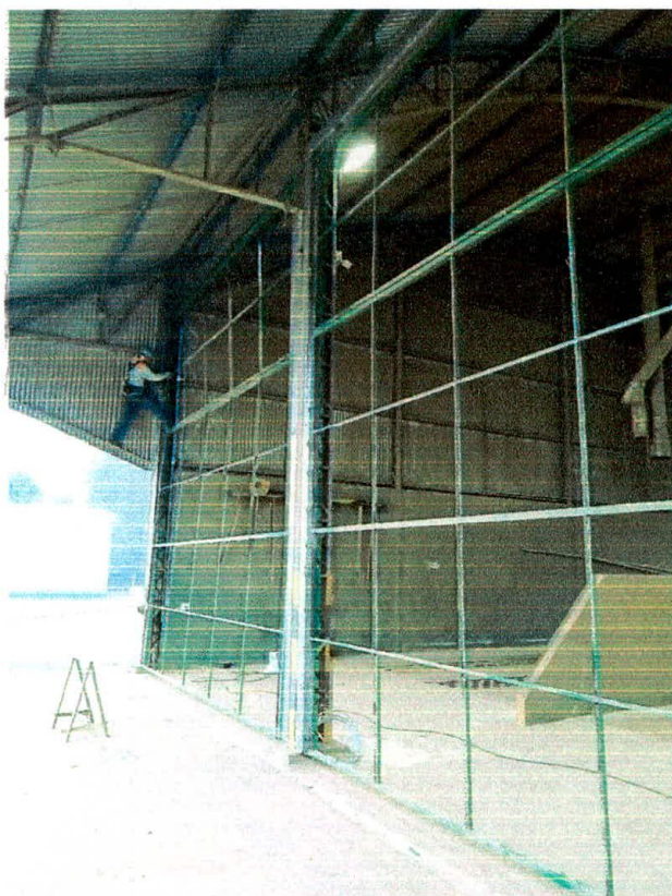
Foto 3 – Instalação de portas com telas de aço com uma malha fina
