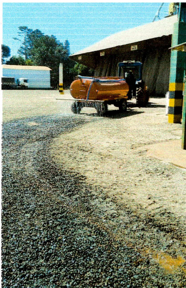
Foto 1: Trator molhando pátio para minimizar dispersão de particulado
