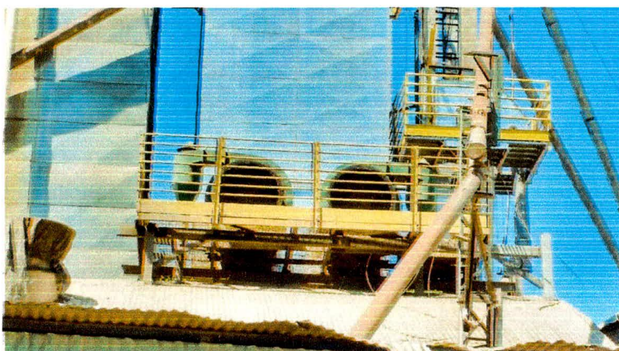
Foto 5 - Captadores de material particulado do secador
