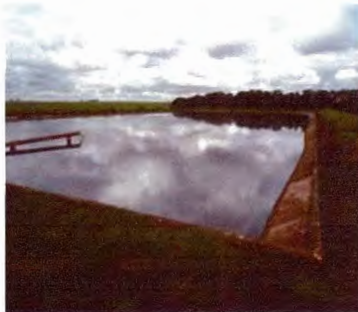
FIGURA 03: Lagoa aeróbica de tratamento de esgoto em Palmital.
